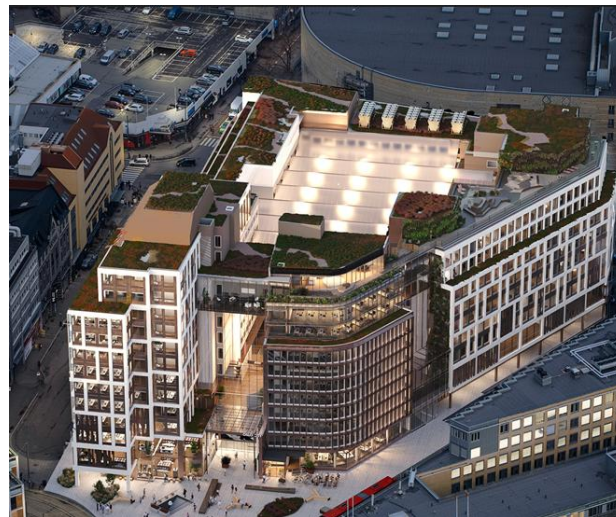
Stenersgata 1 (illustrasjonsfoto). De nyrenoverte kontoretasjene over Oslo City har en av byens beste beliggenheter, og med oppgraderingen som er utført, er deler fasaden blitt ny og det er etablert en helt ny grønn lunge på taket for både folk, flora og fauna.
