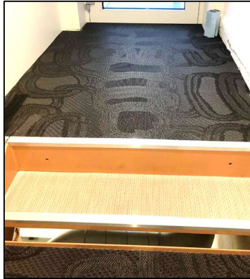
Bolonbelegg (vinyl), lagt i trapp. Foto: Annethe Thorsrud
