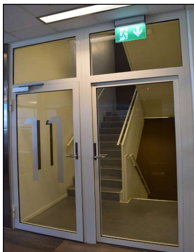
1-2: Dørfelt fra DEG8, overliggende glassfelt fjernet og dør montert i KA13 med ny låssylinder. Foto: Anne S Nordby 3: Brukt brannndør, ferdig montert og lakkert. Foto: Rune Andersen
