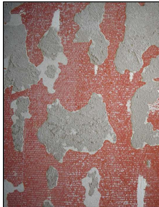
Eksisterende vegg ble rensket, slipt ned og støvbundet. Foto: Rune Andersen og Anne S Nordby
