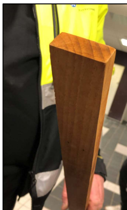
Kraftige håndløpere i tre, som del av rekkverk i Tøyenbadet. Foto: Anne S Nordby
