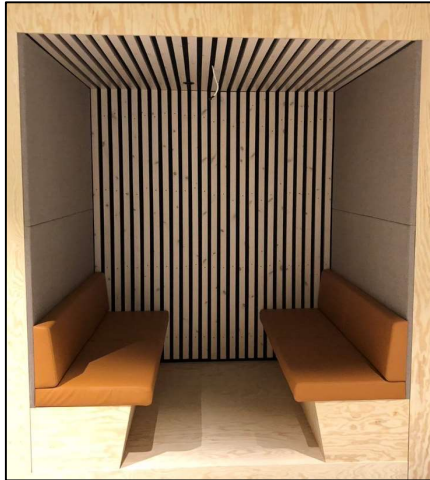
Ferdige sittebåser og kledning av brukte spiler på bakvegg i kinorom. Foto: Rune Andersen
