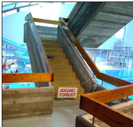
Kraftige håndløpere i tre, som del av rekkverk i Tøyenbadet. Foto: Anne S Nordby
