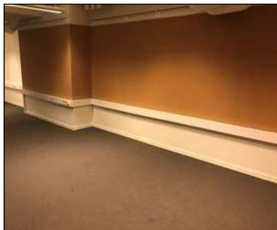
Veggkanaler i plast i KA23 og XRF-måling. Foto: Jennifer Lamson
