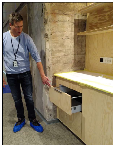
Skrog ferdig montert med nye fronter i 15 mm kryssfiner. Foto: Lars Ulrich Nielson/LUN og Anne S Nordby
