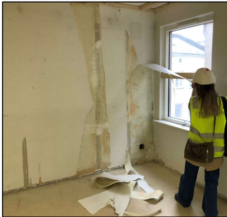
Eksisterende vegg ble rensket, slipt ned og støvbundet. Foto: Rune Andersen og Anne S Nordby
