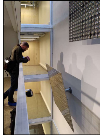
Reflektorer ble demontert fra taket på Tøyenbadet, lagret og til slutt montert i lyssjakt i KA13. Foto: Anne S Nordby
