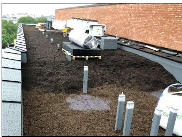
Gjenbruksjord legges på taket. Foto: Rune Andersen
