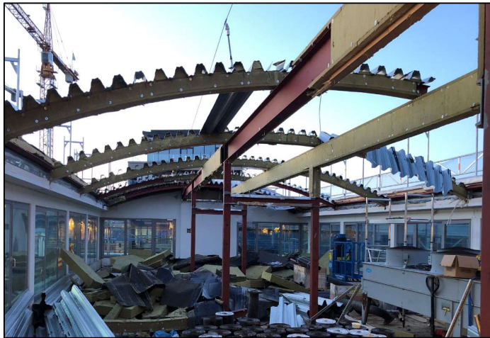
Demontering av stål i Dronning Mauds gate 1-3. Foto Thomas Lindseth
