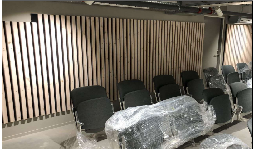
Ferdige sittebåser og kledning av brukte spiler på bakvegg i kinorom. Foto: Rune Andersen
