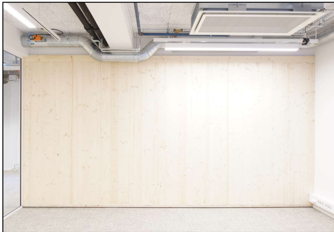
Ferdig vegg. Foto: Kyrre Sundal
