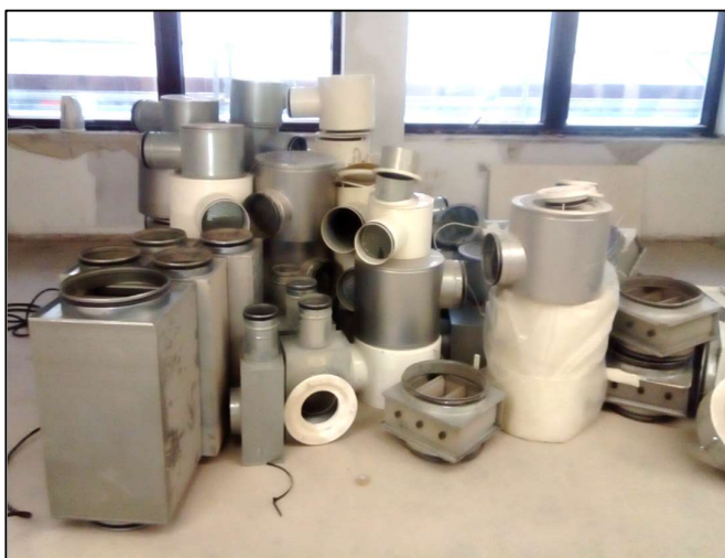
Brukte, runde ventilasjonskanaler og kanalbend - demontert og grovsortert i KA13. Foto: Anne S Nordby
